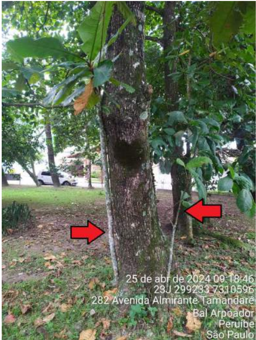
Figura 8: Foto do indivíduo PA6, da espécie Terminalia catappa , conhecida como chapéu-de-sol, com as setas em vermelho indicando ramos de crescimento irregular que precisam ser removidos por apresentarem maior risco de queda devido à fraca ligação com a estrutura lenhosa do tronco principal.
